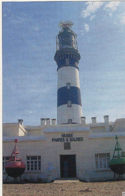
▲ Le musée des Phares et Balises est installé dans l'ancienne habitation des gardiens, au pied du phare.
